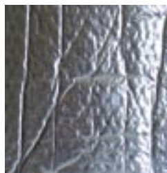
Detail exterieur couverture
